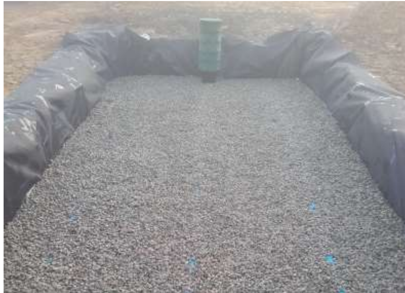
Figure 28 – Mise en place du gravier lavé 10/40 mm
